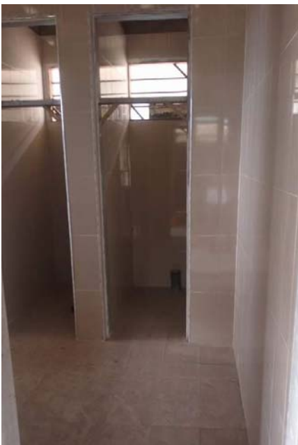
Foto 5: betegelen van de toiletten in januari 2016
